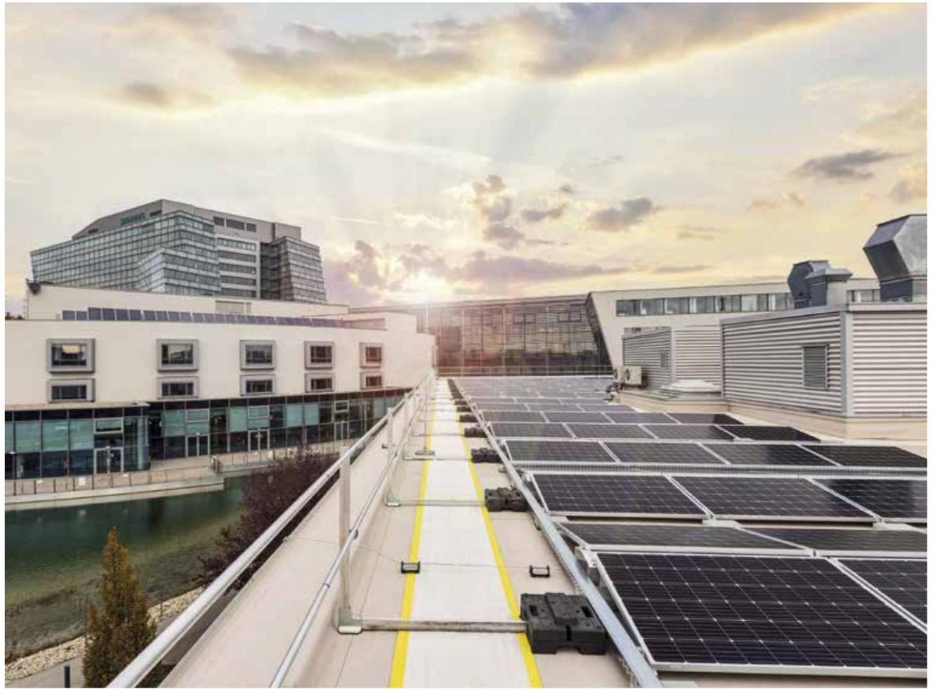
Die in das Siemens-Microgrid integrierten Photovoltaikanlagen umfassen eine Fläche von 1600 m<sup>2</sup>. Mit rund 100 Tonnen CO<sub>2</sub> pro Jahr reduzieren sie den CO<sub>2</sub>-Footprint des Unternehmens.
