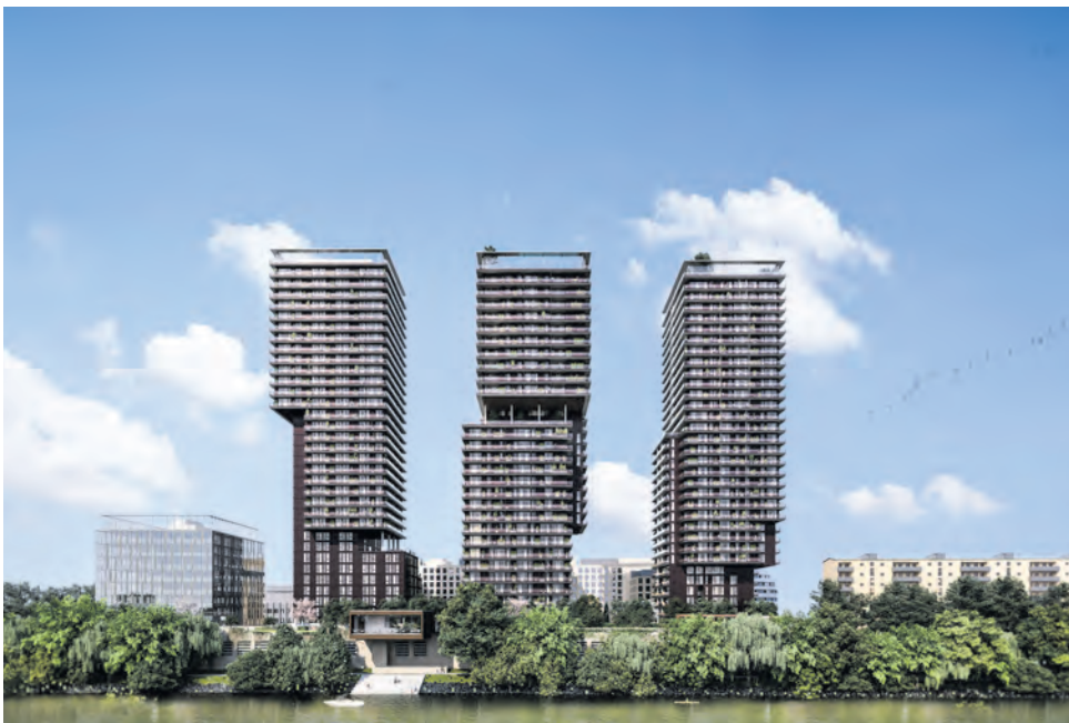
Das Bauprojekt Trillple der SORAVIA-Gruppe nutzt bei den drei Hochhäusern Wasser aus dem Donaukanal für die Klimaversorgung.
